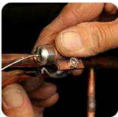
Figura 17. Montaje del bulbo con una grampa/abrazadera
