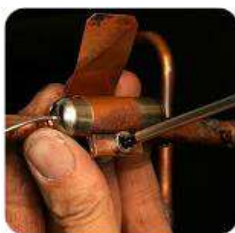
Figura 17. Montaje del bulbo con una grampa/abrazadera
