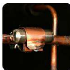
Figura 17. Montaje del bulbo con una grampa/abrazadera
